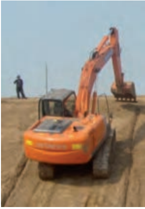
图二：运河修筑中：挖机使用摩巴系统
