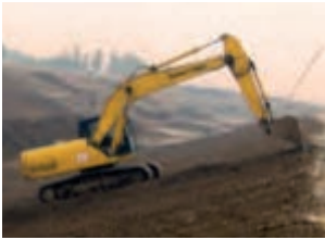
图三：只有达到精确的高度和坡度，才能确保运河修筑后，河流的顺利流通。
